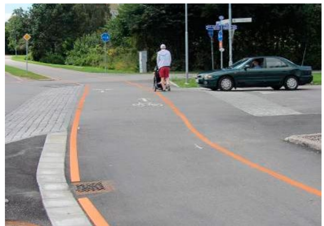
Het kruispunt na de werkzaamheden, met doorlopend fietspad
