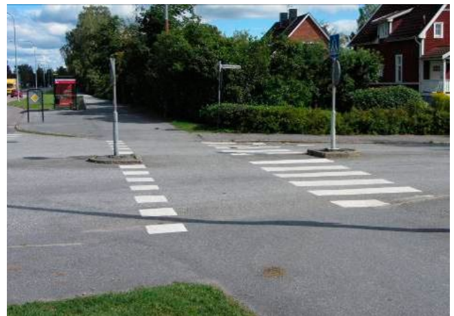
Het kruispunt vóór de werkzaamheden
