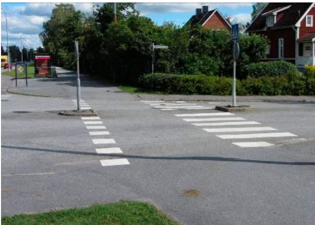
Jonction avant la reconstruction
