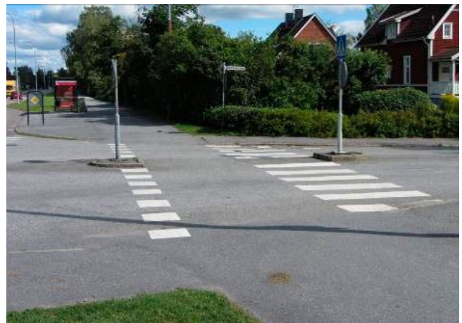
Kreuzung vor dem Wiederaufbau
