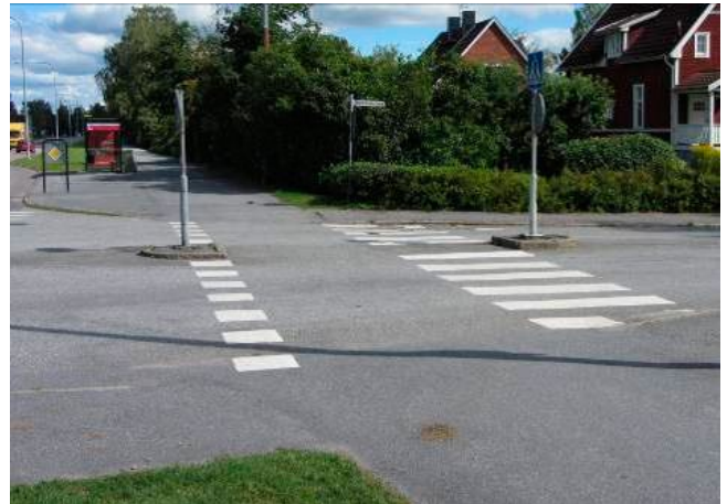
Křižovatka před přestavbou.
