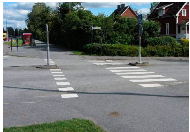
Skrzyżowanie przed przebudową
