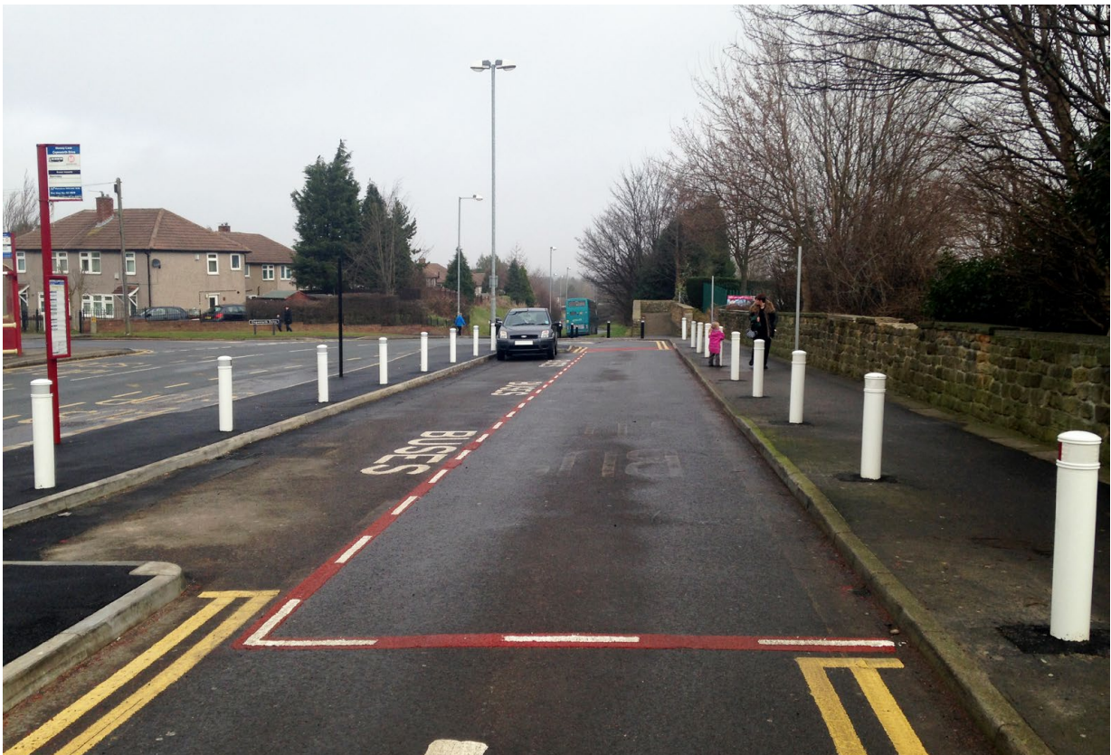
Udoskonalone wyposażenie przystanków autobusowych w Wakefield, finansowane w ramach programu „Bus Hotspots” Zdjęcie: WYCA
